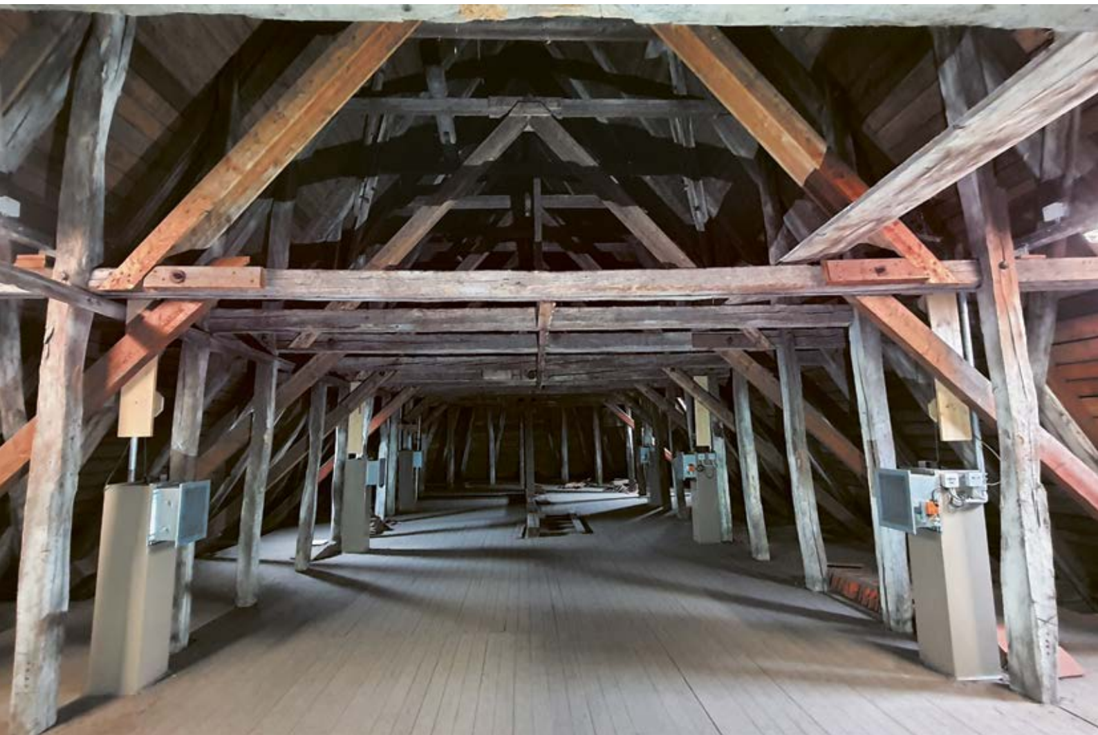
3 Im Chordachraum: Blick nach Osten auf das aus Pappelholz gezimmerte Dachwerk von 1337 (d) mit zusätzlichen Streben des 20. Jahrhunderts.
