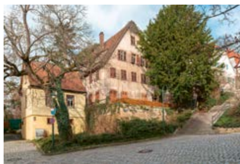
4 Alter Pfarrhof in Weinsberg vor der Maßnahme.
