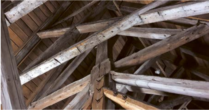
2 Kehlbalken und Streben des gotischen Dachwerks, durchdrungen von barockem Hängewerk und neuzeitlicher Ertüchtigung.
