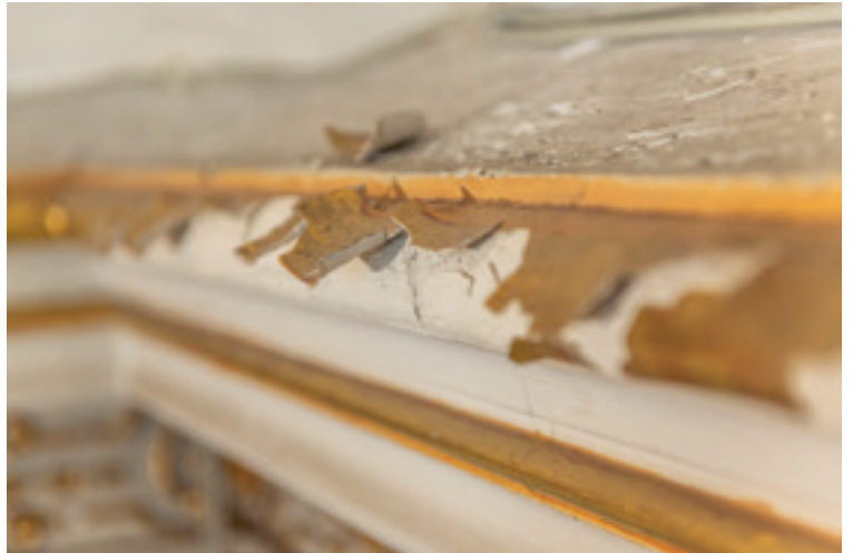
6 Detail aufstehende Metallaufgabe in Raum 137.
