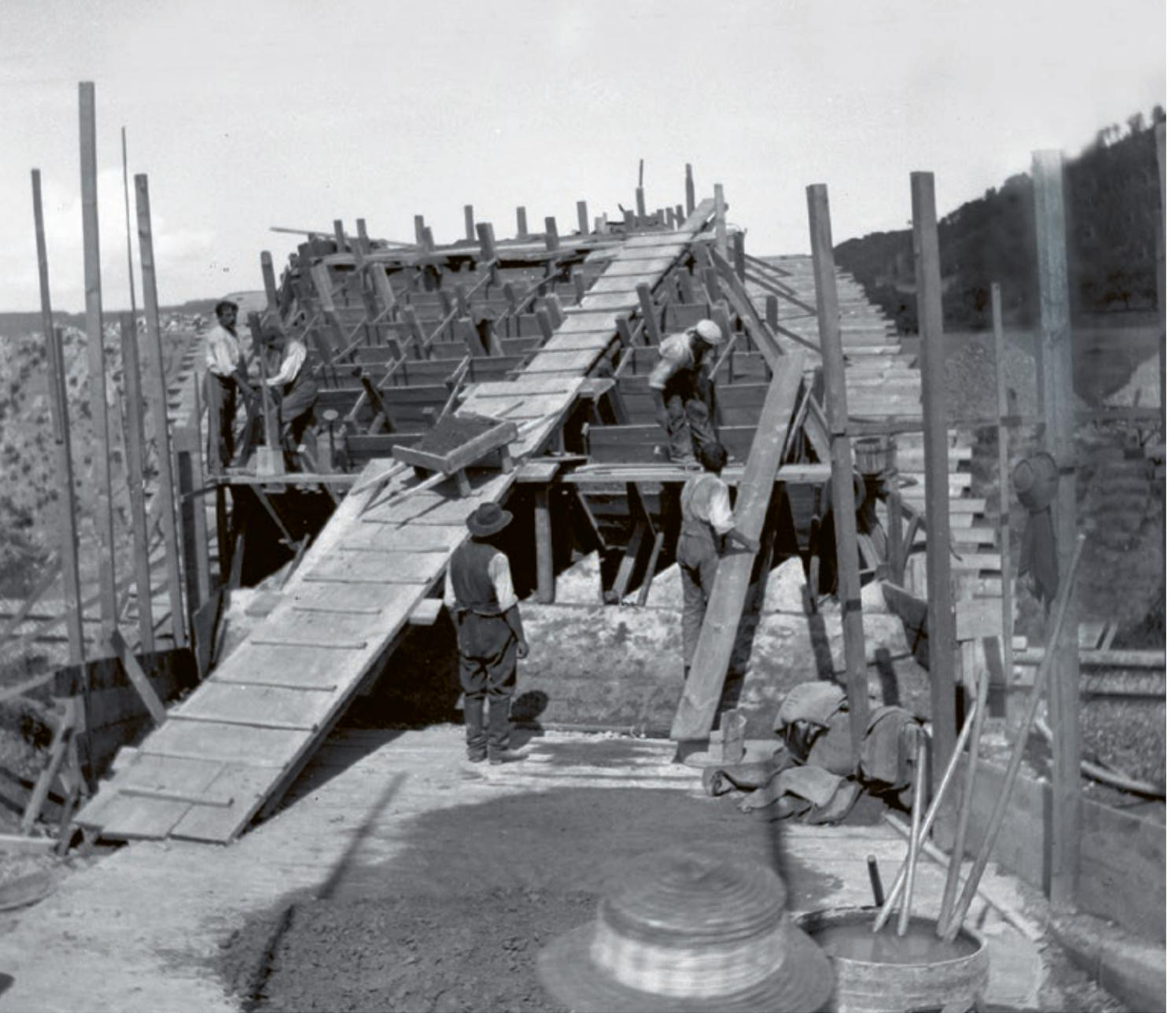
**5** Rampe auf dem zu betonierenden Bogen zur Beschickung der eingeschalteten Lamellen mit Beton.
