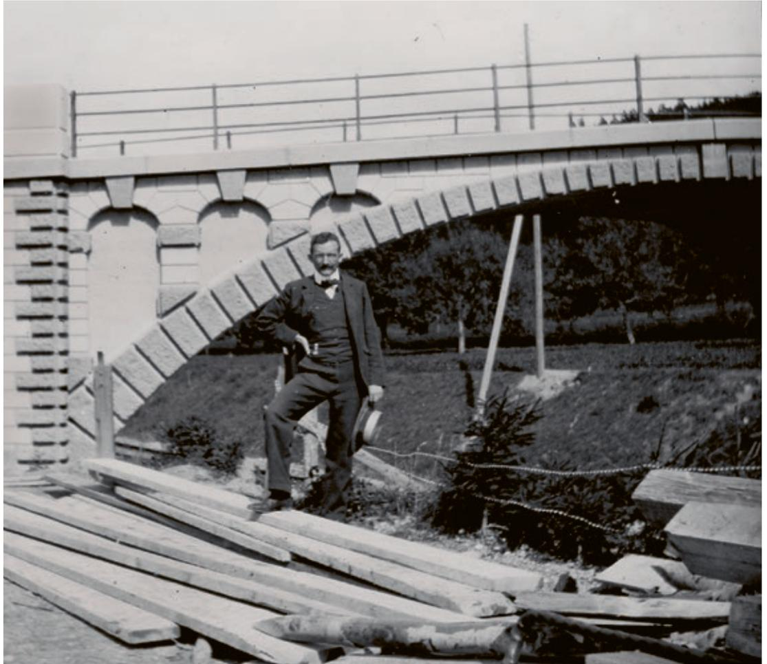
**10** Schalung aus Bohlen und Leisten als Negativ für das Schein-Quadermauerwerk.
