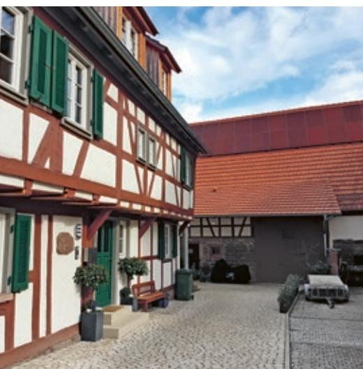
**10** Rote Aufdach-PV-Anlage auf der hofseitigen Dachfläche einer Scheune in Mühlacker-Lienzingen (14. 5. 2025).
