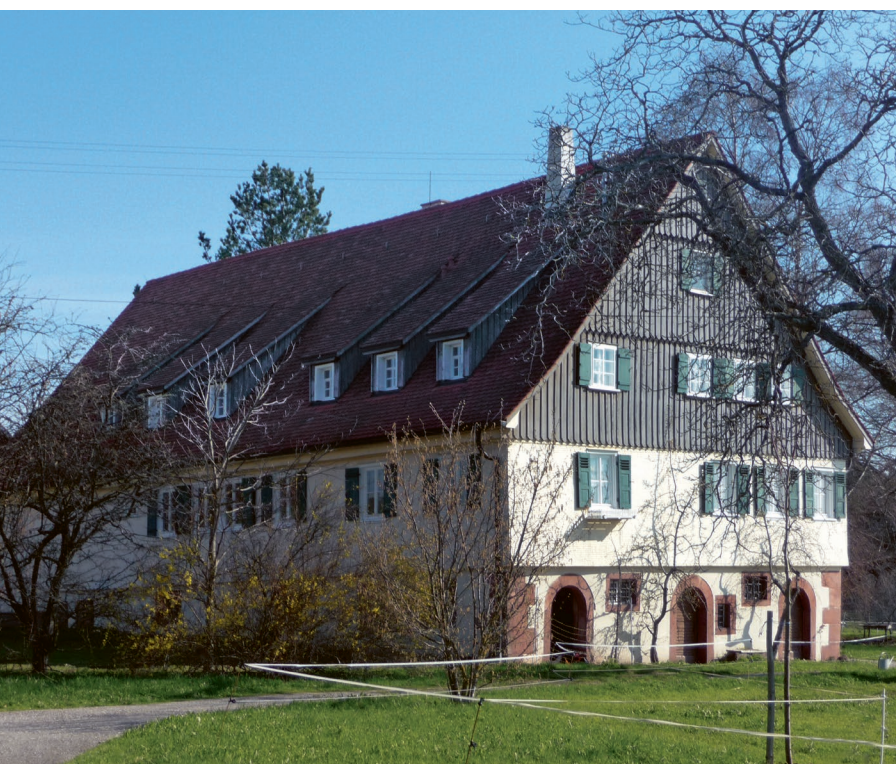
4 Ansicht der Gauben im ausgebauten Dachraum. Die Gauben sind zwischen die Sparren eingepasst.
