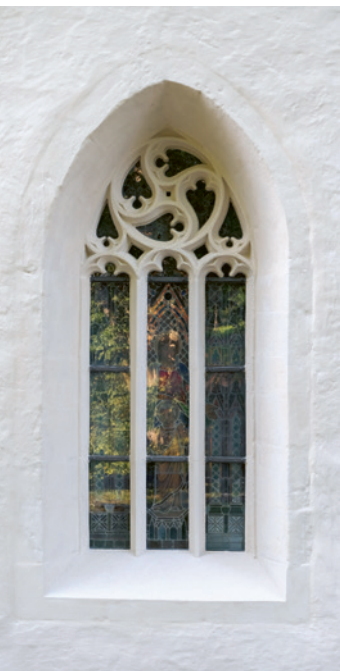
2 Gotisches Chorfenster mit dreiteiligem Maßwerk, Kleeblattbögen und Vierschneuß.
