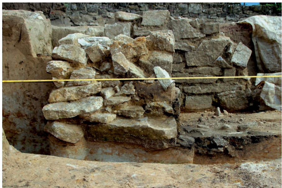
Abb. 5 Bissendorf, Ldkr. Osnabrück. Schnitt durch die Westmauer des Gebäudes, Blick von Süden. An der Innenseite der Mauer ist die verfüllte Baugrube des westlichen Querbalkens zu sehen. Der halbkreisförmige Querschnitt dieses Balkens ist gut zu erkennen (Foto: D. Lau).
