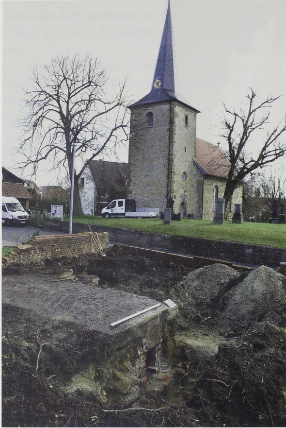
Abb. 180 Gödringen FStNr. 2, Gde. Stadt Sarstedt, Ldkr. Hildesheim (Kat.Nr. 234). Bauplatz im Ortszentrum von Gödringen. Im Vordergrund der zum Bunker umgebaute Gewölbekeller. (Foto: S. Agostinnetto)
