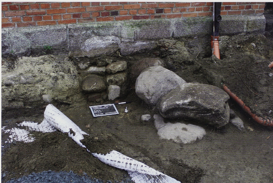
Abb. 324 Horneburg FStNr. 257, Gde. Flecken Horneburg, Ldkr. Stade (Kat.Nr. 447) Findlingsfundament unter der nördlichen Kirchenwand. (Foto: S. Düvel)
