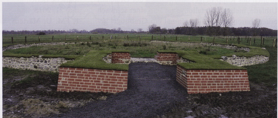
Abb. 38 Stotel FStNr. 54, Gde. Loxstedt, Ldkr. Cuxhaven (Kat.Nr. 61). Ringmauer und Turm der Burg Stotel nach Abschluss der Sanierung im Jahr 2018. (Foto: A. Hüser)
