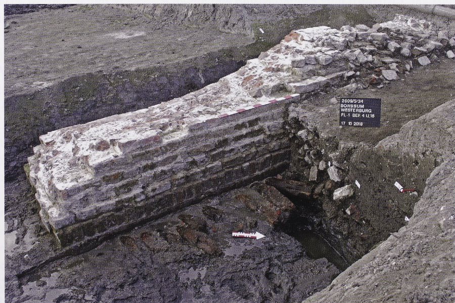
Abb. 52 Borssum FStNr. 5, Gde. Stadt Emden, KfSt. Emden (Kat.Nr. 88). Ansicht auf ein Teilstück der Mauer mit Blick auf die hölzerne Substruktion. (Foto: I. Reese)
