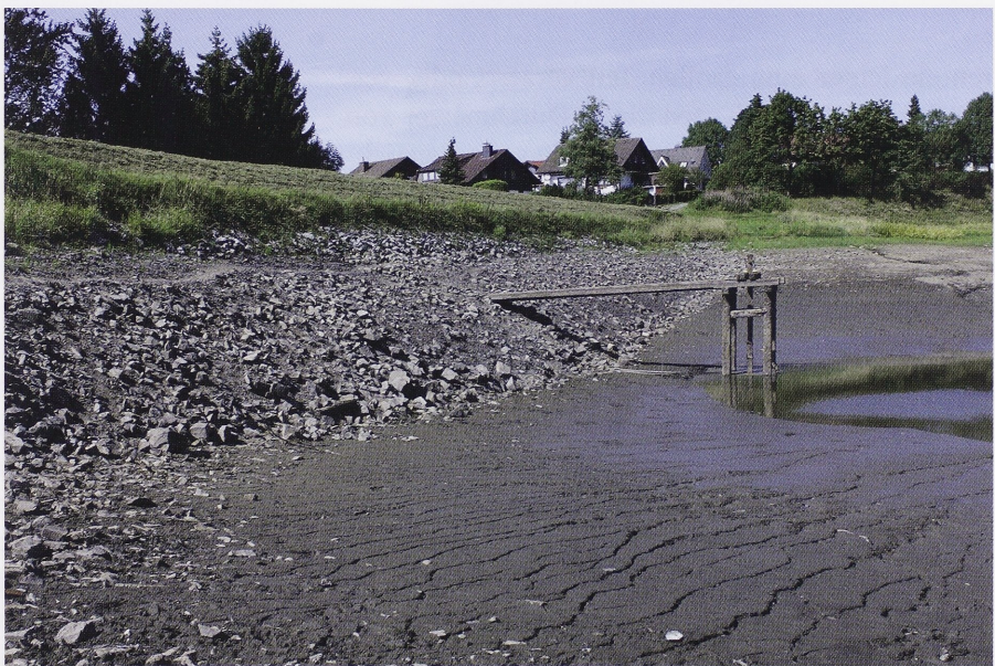
Abb. 80 Clausthal FStNr. 147, Gde. Clausthal-Zellerfeld, Ldkr. Goslar (Kat.Nr. 122). Das Striegelgerüst am unteren Teichdamm. (Foto: K. Malek)
