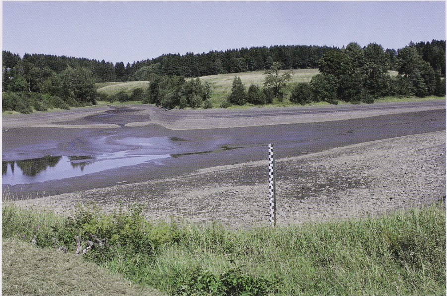
Abb. 79 Clausthal FStNr. 147, Gde. Clausthal-Zellerfeld, Ldkr. Goslar (Kat.Nr. 122). Die drei oberen Dämme der Teichkaskade, Blick nach NO. (Foto: K. Malek)
