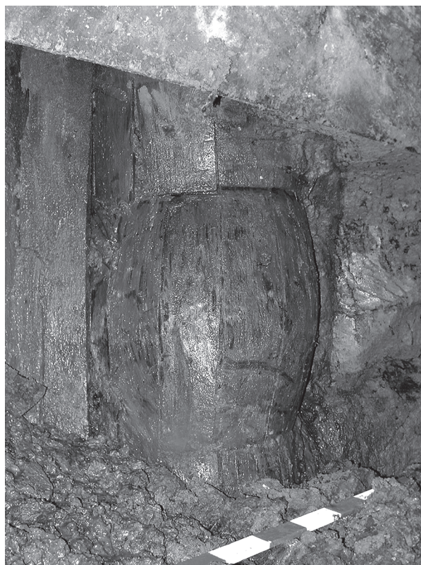
Abb. 205 Emden OL-Nr. 2609/1:74, Gde. Stadt Emden, KfSt. Emden (Kat.Nr. 258) Der Fassschacht aus Abb. 203 in größerer Tiefe. Links daneben sind die Spundwände der Holzverschalteten Zisterne erkennbar. (Foto: S. Busch-Hellwig)
