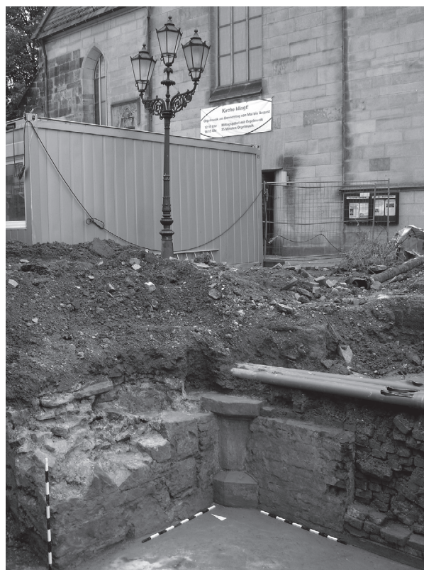
Abb. 97 Hameln FStNr. 179, Gde. Stadt Hameln, Ldkr. Hameln-Pyrmont (Kat.Nr. 116) Freigelegter Kellerraum des ehemaligen Rathauses mit Stützpfeiler des Gewölbes. (Foto: J. Schween)
