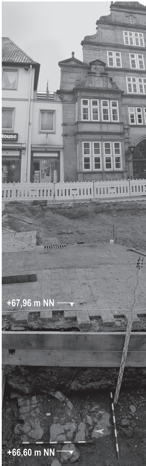
Abb. 51 Hameln FStNr. 130, Gde. Stadt Hameln, Ldkr. Hameln-Pyrmont (Kat.Nr. 55). Leitungsgraben Bäckerstraße mit Resten eines mittelalterlichen Bruchsteinpflasters (Pflaster II). Hinten rechts Haus Nr. 16 (Rattenkrug), Blick nach Osten. (Foto: J. Schween)
