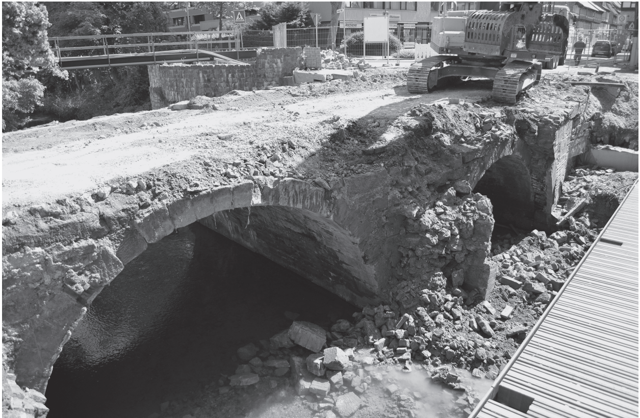
Abb. 156 Einbeck FStNr. 216, Gde. Stadt Einbeck, Ldkr. Northeim (Kat.Nr. 226). Abrissarbeiten der Brückenteile des 19. und 20. Jahrhunderts. (Foto: S. Teuber)
