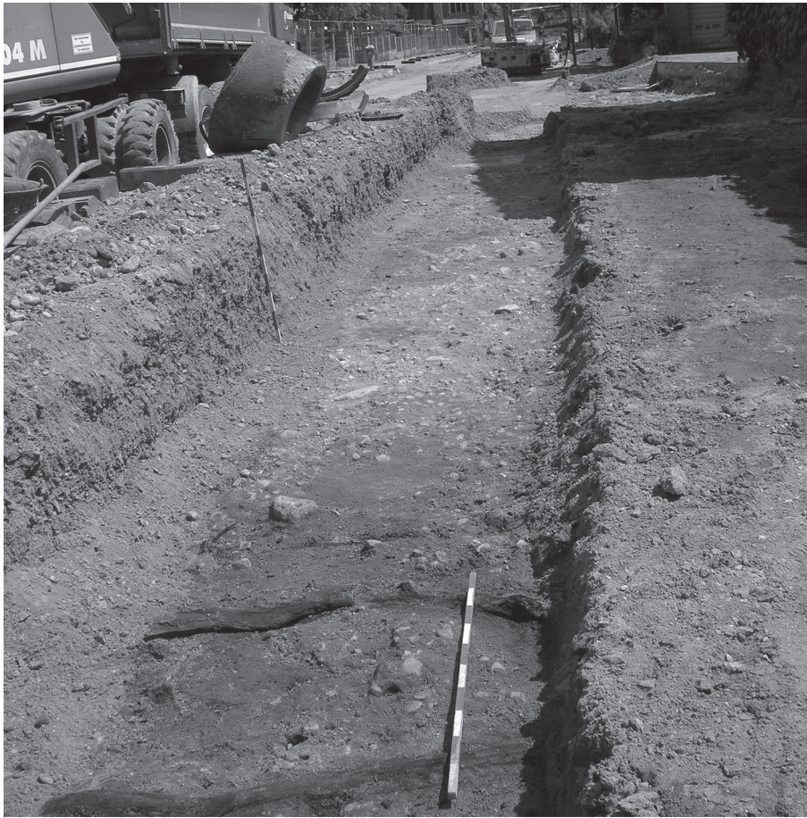
Abb. 179 Duttonstedt FStNr. 14, Gde. Stadt Peine, Ldkr. Peine (Kat. Nr. 263). Freigelegtes Teilstück der Altstraße unter der Eilhardt-von-Oberg-Straße. Tiefe: 0,85 m unter der früheren Straßenoberfläche, die hier schon beseitigt ist. (Foto: T. Budde)
