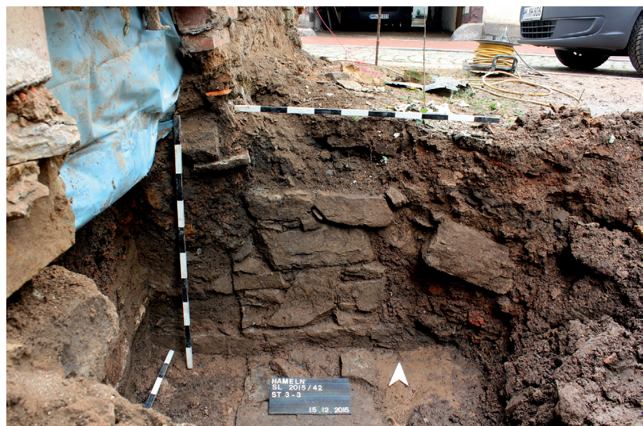
Abb. 73 Hameln FStNr. 236, Gde. Stadt Hameln, Ldkr. Hameln-Pyrmont (Kat.Nr. 116). Bei Sicherungsmaßnahmen angeschnittenes spätmittelalterlich-frühneuzeitliches Gebäudefundament an der Parzellengrenze Neue Marktstraße Nr. 1 zu 2 sowie darunter quer liegendes parzellenübergreifendes Fundament einer Gebäudestraßenfront. Blick gegen Norden. (Foto: J. Schween)
