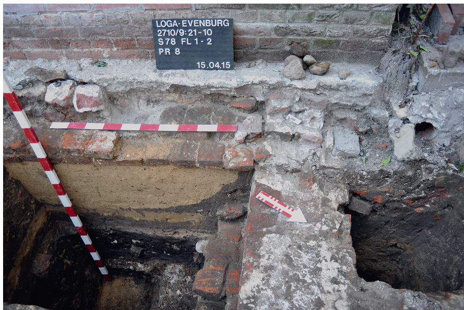
Abb. 115 Loga FStNr. 11, Gde. Stadt Leer, Ldkr. Leer (Kat.Nr. 187). Unter der heutigen Außenmauer der Vorburg kam bei den Erdarbeiten älteres Mauerwerk zutage. Im Bild sichtbar ist die Sandunterlage im Fundamentierungsgraben. An der Basis des Schnittes ist der Muschelkalk der spätmittelalterlichen Relikte zu erkennen. (Foto: A. Hüser)
