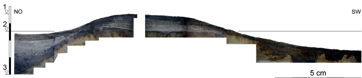
Abb. 22 Sahlenburg FStNr. 18, Gde. Stadt Cuxhaven, Ldkr. Cuxhaven (Kat.Nr. 22). Gesamtprofil, Montage aus mehreren Einzelaufnahmen: 1 erhaltene Wallhöhe (+13,9 m NN), 2 vorwallzeitliche Geländehöhe (+12,9 m NN), 3 Grabensohle (+10,28 m NN). (Fotos und Bearbeitung: U. Kraus)
