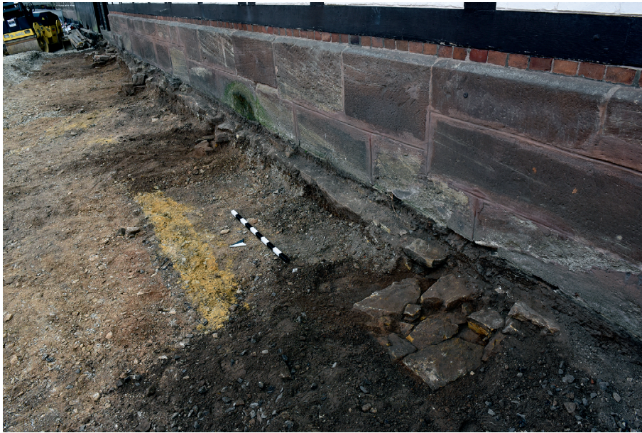
Abb. 54 Bovenden FStNr. 39, Gde. Flecken Bovenden, Ldkr. Göttingen (Kat.Nr. 55). Mittelalterliche Fundamentreste unter dem heutigen Gebäude. (Foto: M. Beuermann)
