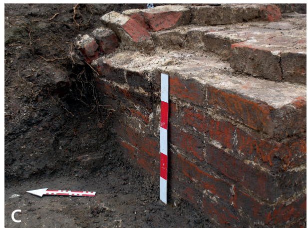
Abb. 77 Borssum FStNr. 4A, Gde. Stadt Emden, KfSt. Emden (Kat.Nr. 54). A Ansatz des Entlastungsbogens im Mauerverband von Bef. 3 und 2. Darüber sind auch zwei Lagen aus bogenförmig angeordneten Katzenköpfen und Backsteinen zu erkennen, die den ehemaligen Bogenscheitel zu markieren scheinen, B Ansatz des Bogens an Bef. 3, C Ansatz des Bogens an Bef. 2. (Fotos: W. Schwarze)
