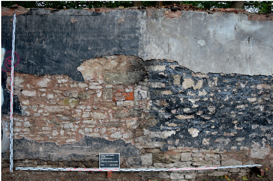
Abb. 108 Göttingen FStNr. 66, Gde. Stadt Göttingen, Ldkr. Göttingen (Kat.Nr. 81). Mauerabschnitt mit zugesetzter Schießscharte. (Foto: O. Oliefka)
