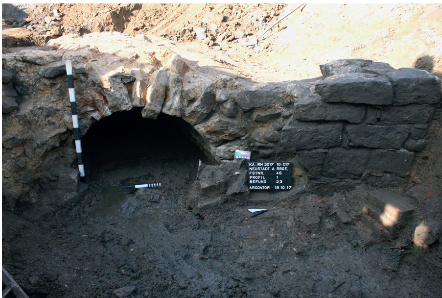
Abb. 133 Neustadt a. Rbge. FStNr. 46, Gde. Stadt Neustadt a. Rbge., Region Hannover (Kat.Nr. 126). Der östliche Abschluss des neuzeitlichen Gewölbekanals mit noch teilweise erhaltener Blendmauer. Das rezente angesetzte Betonrohr war zum Zeitpunkt der Aufnahme schon entfernt worden. (Foto: M. Fischer)
