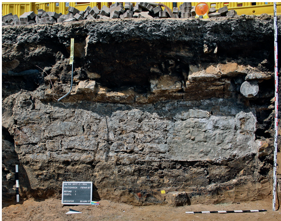
Abb. 135 Pattensen FStNr. 67, Gde. Stadt Pattensen, Region Hannover (Kat.Nr. 134). Westwand des während der Baugrubenherstellung abgebrochenen Gewölbekellers mit teilweise noch erhaltenem Kalkputz. (Foto: K. Vahl)
