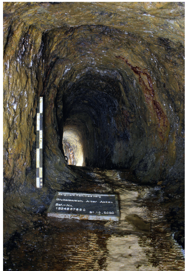
Abb. 99 Goslar FStNr. 70, Gde. Stadt Goslar, Ldkr. Goslar (Kat.Nr. 133). Blick in die Strecke 2 mit charakteristisch rundlichem Profil. (Foto: G. Drechsler)
