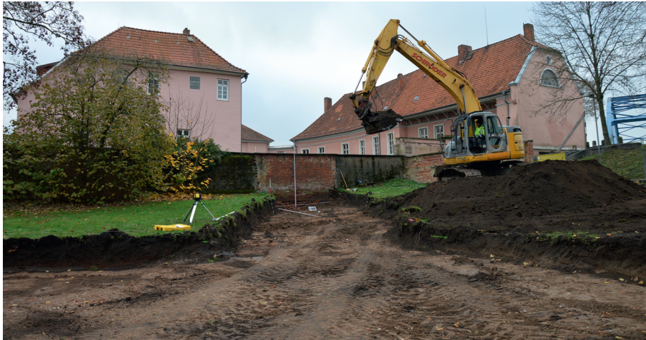
Abb. 211 Hoya FStNr. 6, Gde. Stadt Hoya, Ldkr. Nienburg (Weser) (Kat.Nr. 281). Bodenabtrag für die geplante Schlosszufahrt, die im Bereich einer neuzeitlichen „Ziegelplombe“ in der über 2 m hoch erhaltenen historischen Mauer angelegt ist. (Foto: D. Rathert)
