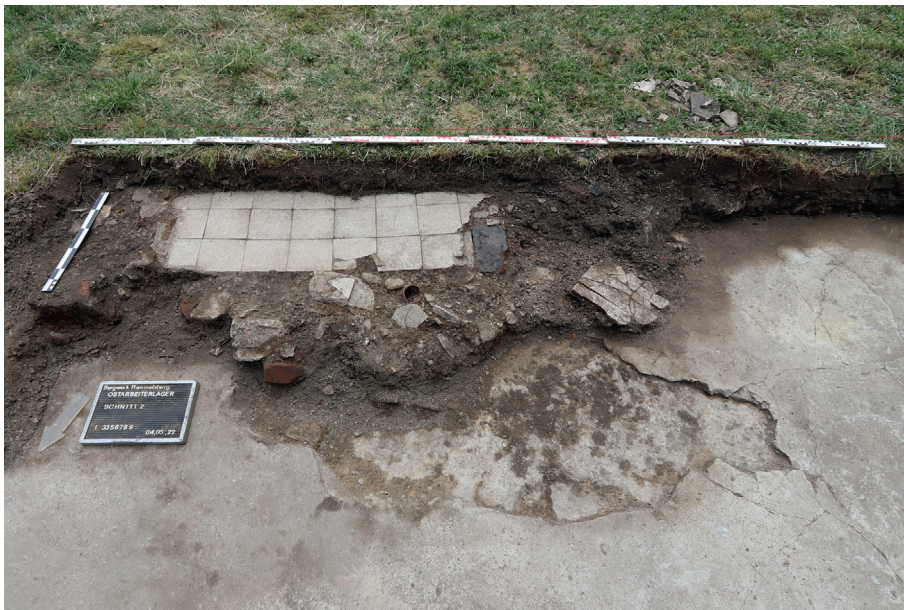
Abb. 96 Goslar FStNr. 179, Gde. Stadt Goslar, Ldkr. Goslar (Kat.Nr. 158). Ausgrabung von Schnitt 2 an der Wasch- und Abortbaracke. Am unteren Bildrand ist der Betonboden zu sehen, am oberen Bildrand die Bodenfliesen einer Nasszelle. (Foto: G. Drechsler)
