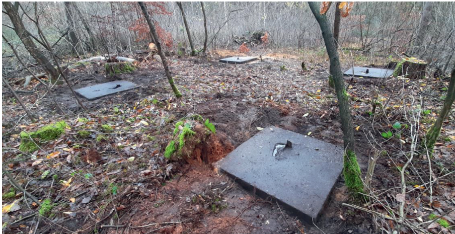
Abb. 242 Rehburg FStNr. 122, Gde. Stadt Rehburg-Loccum, Ldkr. Nienburg (Weser) (Kat. Nr. 341). Im Wald freigelegte Punktfundamente für einen Wachturm im Arbeitslager. (Foto: R. Reimann)
