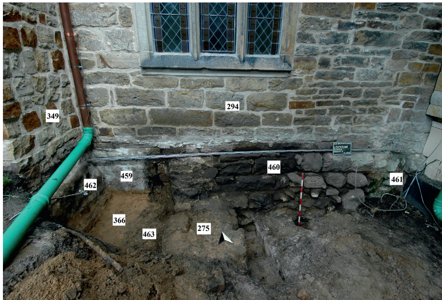
Abb. 235 Loccum FStNr. 1, Gde. Stadt Rehburg-Loccum, Ldkr. Nienburg (Weser) (Kat.-Nr. 335). Blick auf ausgeschachtete Fläche vor dem Südflügel. Blick nach Norden. (Foto: R. Landwehr)
