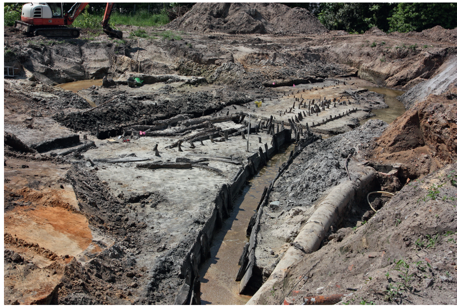
Abb. 272 Quakenbrück FStNr. 60, Gde. Stadt Quakenbrück, Ldkr. Osnabrück (Kat.Nr. 401). Blick auf die Grabungsfläche mit Uferrandbefestigungen des ehemaligen Mühlenkolkes und einem hölzernen Gerinne, das möglicherweise als eine Art Umflut (sog. „Wildwasser“) fungiert hat. (Foto: Stadt- und Kreisarch. Osnabrück)
