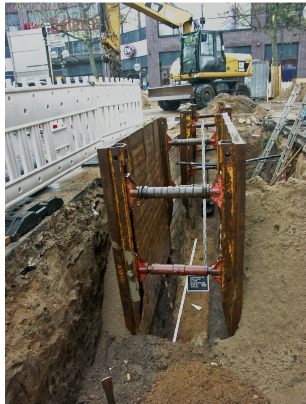
Abb. 300 Peine FStNr. 161, Gde. Stadt Peine, Ldkr. Peine (Kat.Nr. 444). Die Sohle der neu entdeckten breiten Begleitgräben der Peiner Ausfallstraße nach Süden lag in bis zu 3m Tiefe und konnte nur mühsam unter Verbau aufgenommen werden. (Foto: T. Budde)
