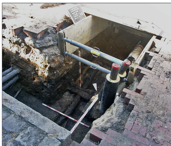
Abb. 299 Peine FStNr. 160, Gde. Stadt Peine, Ldkr. Peine (Kat.Nr. 443). Im neuen Fernwärme-Leitungsgraben unter dem Echternplatz kam die Substruktion der stadtgründungszeitlichen Echternstraße, bestehend aus längs und quer verlegten Eichenbalken, zutage (13. Jh.). (Foto: T. Budde)
