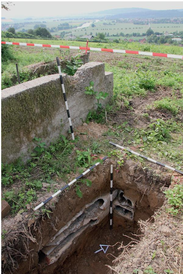
**Abb. 109** Hagenohsen FStNr. 13, Gde. Emmerthal, Ldkr. Hameln-Pyrmont (Kat.Nr. 160). Dokumentations- und Lernort Bückeberg, ehemalige Ehrentribüne. Angeschnittene Leerrohrsteine (sog. Kabelzugplatten) der ehemaligen technischen Infrastruktur in der Baugrube für Fundamente eines neuen Besuchersteiges, östlich des Mittelweges. (Foto: J. Schween)
