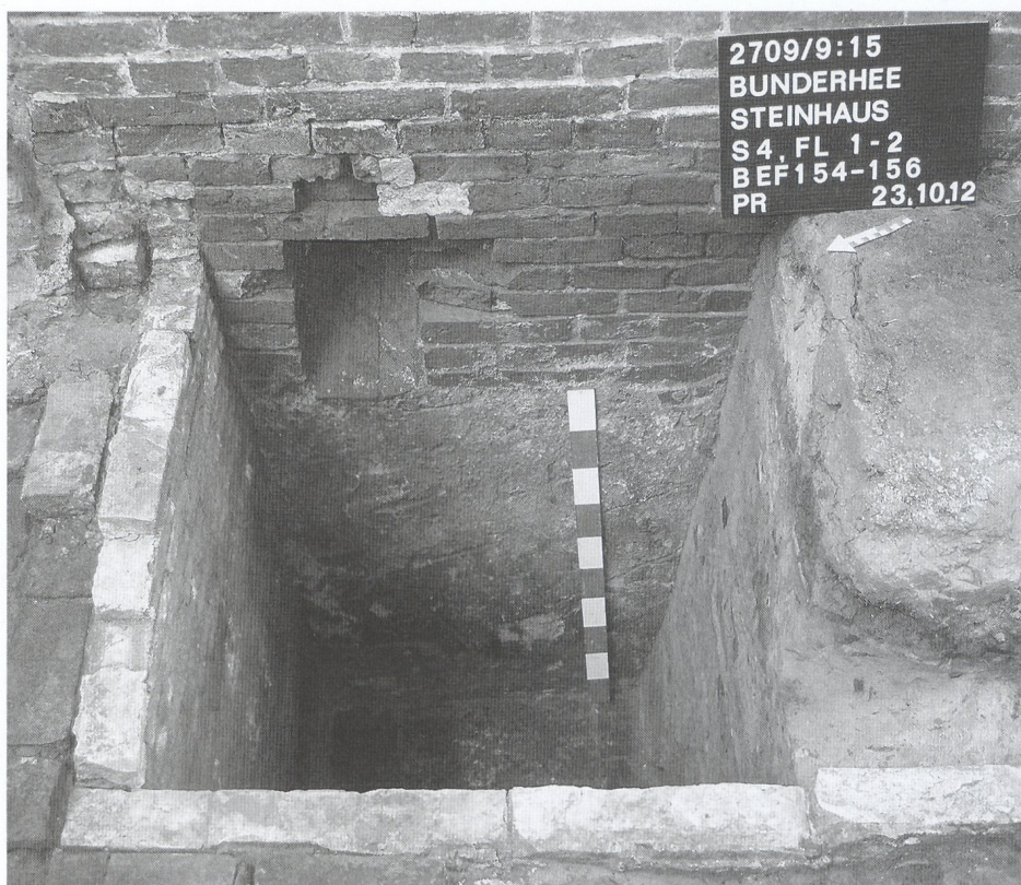
Abb. 129 Bunderhee FStNr. 1, Gde. Bunde, Ldkr. Leer (Kat.Nr. 152) Steinhaus Bunderhee, Sanitärutsche und Reservoir in der Giebelwand des barocken Anbaues. (Foto A. Prussat)
