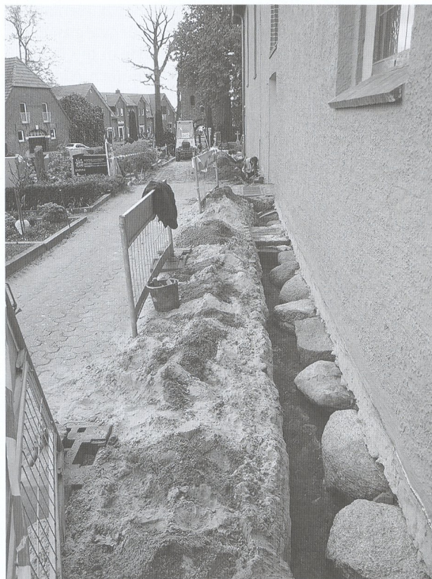
Abb. 173 Wardenburg FStNr. 41, Gde. Wardenburg, Ldkr. Oldenburg (Kat.Nr. 201) Mittelalterliches Findlingsfundament der Wardenburger Kirche. (Foto: A. Hummel)
