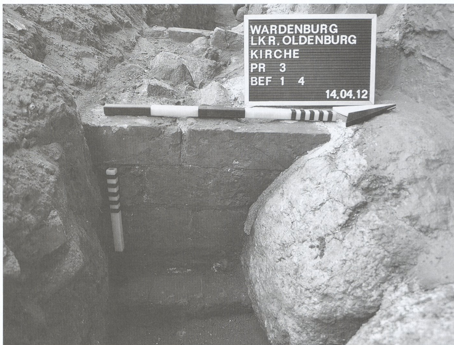
Abb. 174 Wardenburg FStNr. 41, Gde. Wardenburg, Ldkr. Oldenburg (Kat.Nr. 201) Strebepfeilerfundament setzt an das Findlingsfundament des Kirchenschiffes an. (Foto: A. Hummel)
