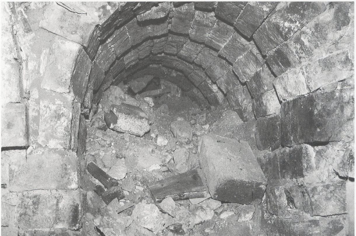
Abb. 97 Einbeck FStNr. 80, Gde. Stadt Einbeck, Ldkr. Northeim (Kat.Nr. 223) Blick in den Feuerungsraum der Steinspeicher-Warmluftheizung im Keller unter dem kleinen Ratssaal des Einbecker Rathauses.
