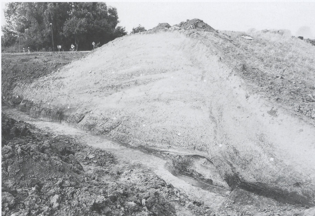
Abb. 127 Bohnenburg FStNr. 1, Gde. Amt Neuhaus, Ldkr. Lüneburg (Kat.Nr. 235) Deichschnitt mit einzelnen Bauphasen. (Foto: J. von Dein)
