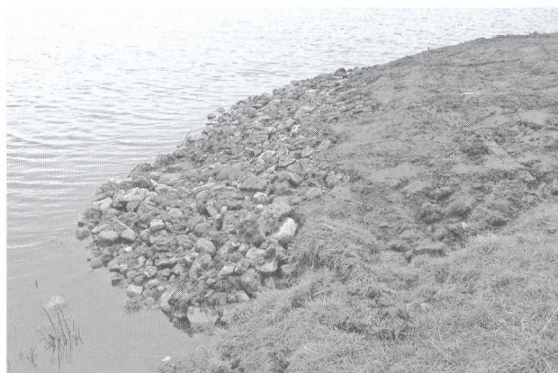
Abb. 202 Engehausen FStNr. 11, Gde. Essel, Ldkr. Soltau-Fallingb. (Kat.Nr. 212) Uhlenburg. Sicherungsmaßnahme 2004 gegen Erosions- und Trittschäden am Südrand der Hauptburg. Nachhaltiger Schutz ist gewährleistet. (Foto: H.-W. Heine)
