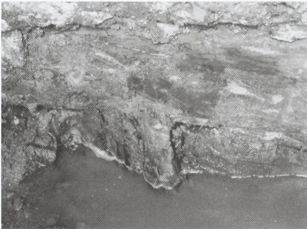
Abb. 199 Salder FStNr. 36, Gde. Stadt Salzgitter, KfSt. Salzgitter (Kat.Nr. 183) Detail vom Unterbau des Schafstalls: abgehender Stützpfiler mit darüber liegendem Schwellbalken. (Foto: Chr. Kellner-Depner)
