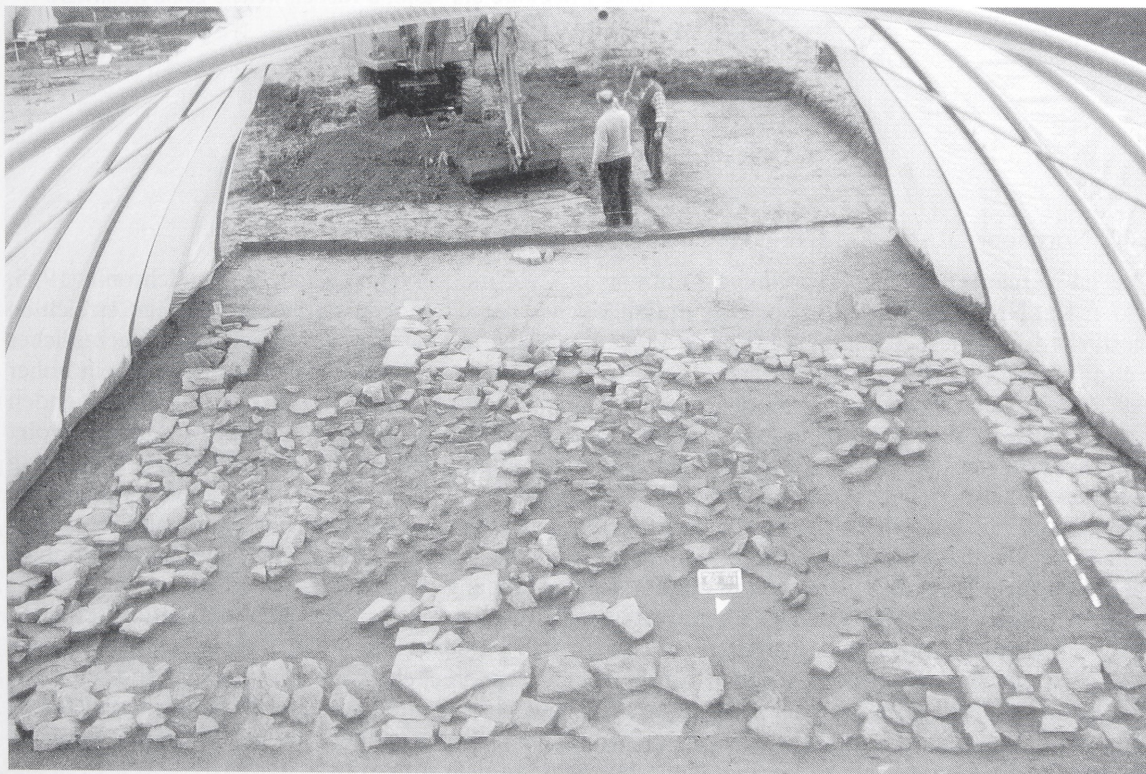
Abb. 79 Nienover FStNr. 2, Gde. Flecken Bodenfelde, Ldkr. Northeim (Kat.Nr. 261). Stadtwüstung Nienover. Blick von Norden auf das Fundament eines Steinwerks der Zeit um 1200.
