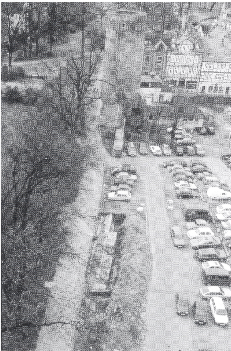
Abb. 110 Münden FStNr. 120, Gde. Stadt Hann. Münden, Ldkr. Göttingen (Kat.Nr. 320). Blick vom Hampe'schen Turm auf das freigelegte Stadtmauerfundament mit vorgelegter Fundamentverstärkung (rechts) und Kronenturm (hinten).
