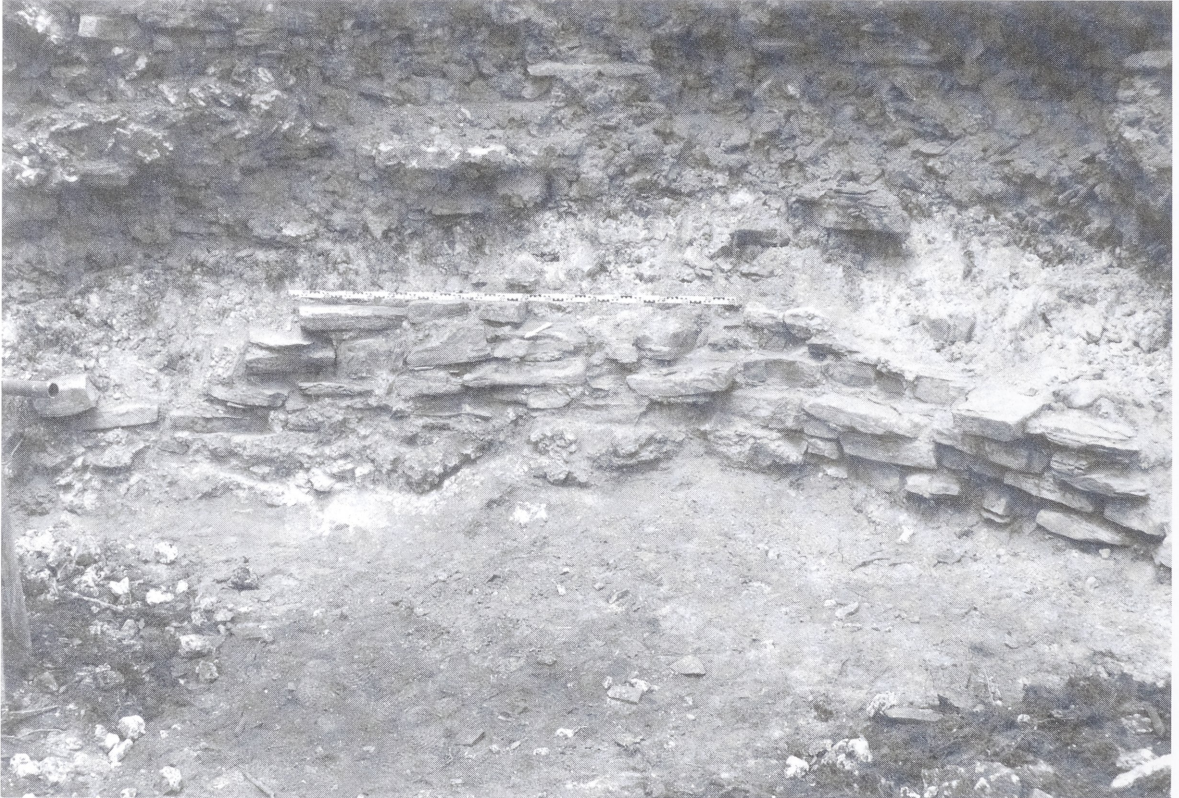
Abb. 94 Walkenried-Forst FStNr. 1, GfG. Harz, Ldkr. Osterode am Harz (Kat.Nr. 368). Innere Mauerschale des großen Rundturms.
