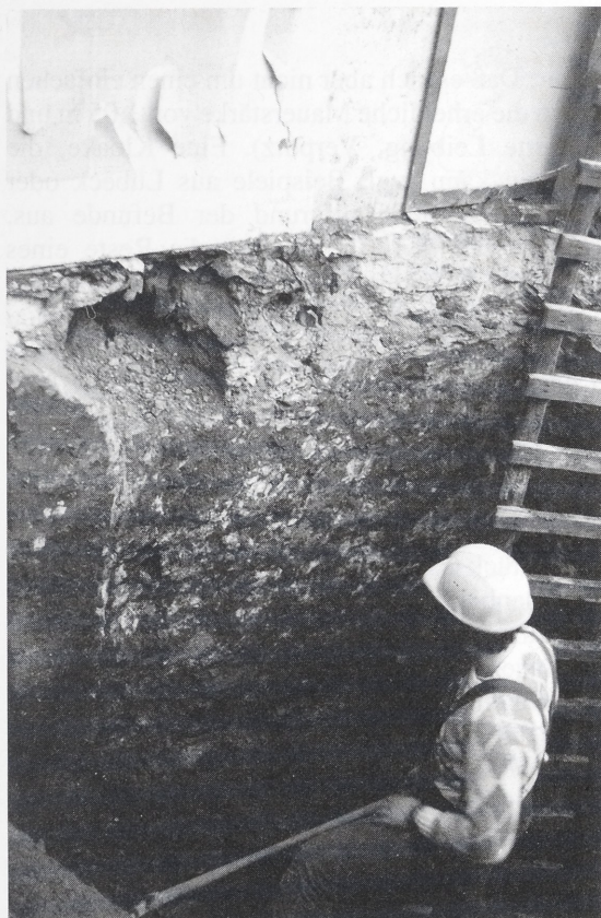
Abb. 4 Hameln, Ldkr. Hameln-Pyrmont, Notbergung Osterstraße 6. Mittelalterliches Steinwerk. Mauerstück mit Schlemmüberzug. Links: Türleibung (vgl. Abb. 3).
