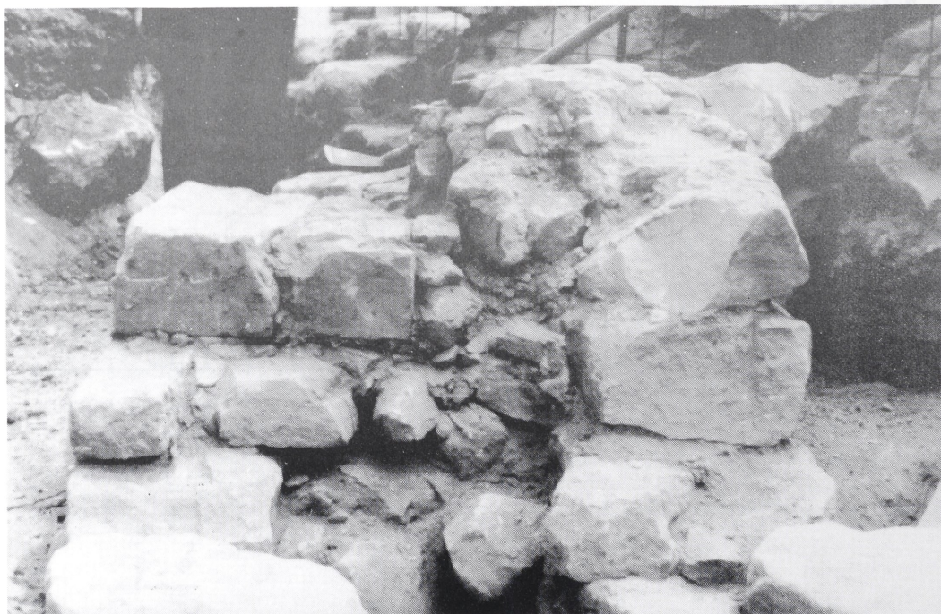
Abb. 14 Schöner Rundturm, 2-Schalen-Mauer mit vermörtelter Füllung.
