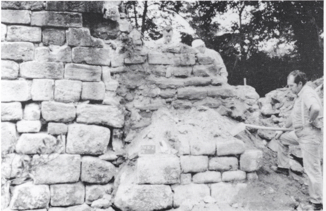
Abb. 19 Ältere, rote Sandsteinmauer als „Füllung“ der späteren Mauer.
