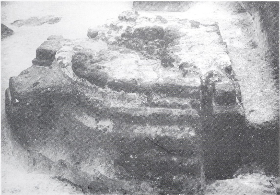
Abb. 17 Burg in Altencelle (Stadt Celle, Ldkr. Celle). Kamin von Westen mit Nute für aufgehende Holzwand (Detail vom Bauernhaus über der Halle).
