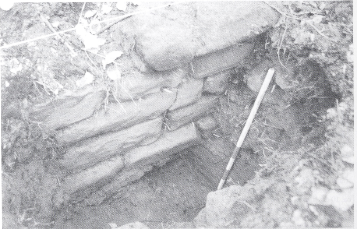
Abb. 4 Groß Lengden, Ldkr. Göttingen, Hünsche Burg. Freigelegte Ringmauer im Ostwall (Außenfassade).
