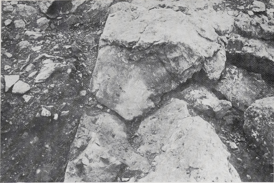
1 Blockstufe. Platte mit Furche, in die halbkuglige Konkretion durch Behauen eingepaßt ist.
