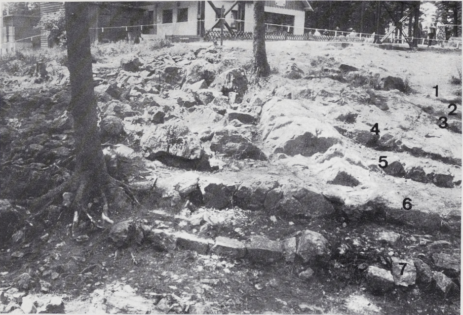
2 Blick auf das Stufenfeld in Höhe der Felsrippe. 1-7 Steinstufen.
