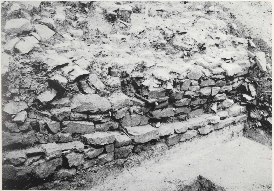
2 Mörtelmauer als Wallverstärkung an der Südflanke der Unterburg
