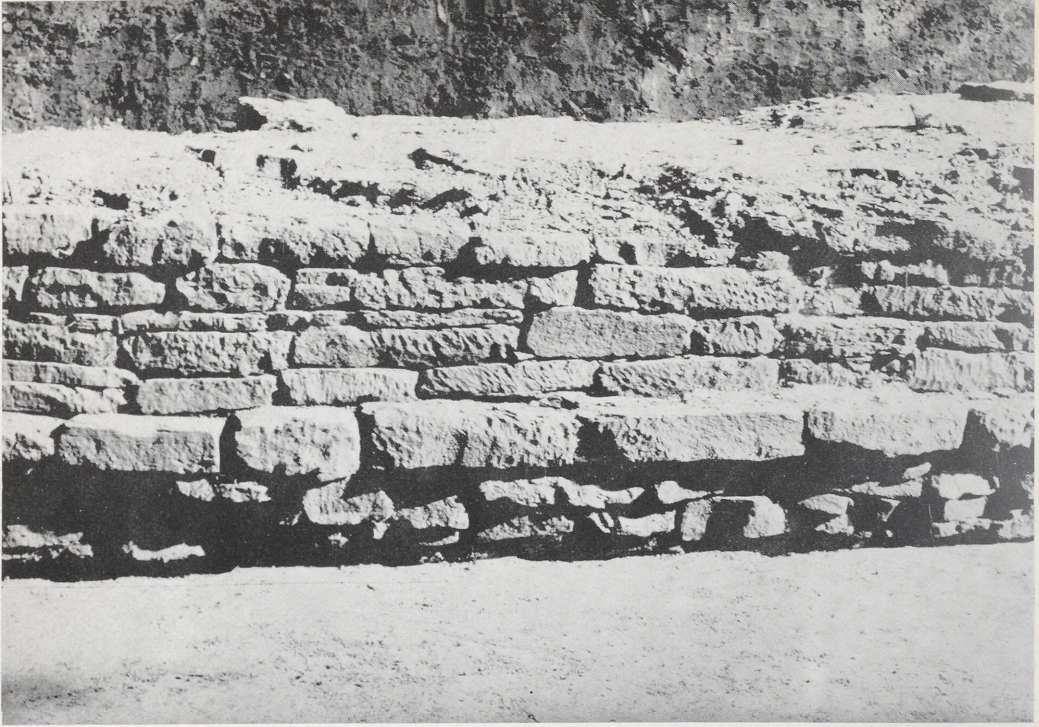
1 Außenfront der Oberburgmauer
