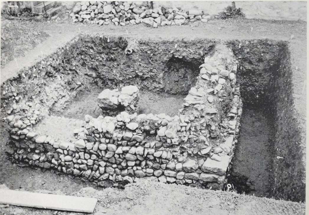
2 Mauerreste an der Nordseite der Kirche
