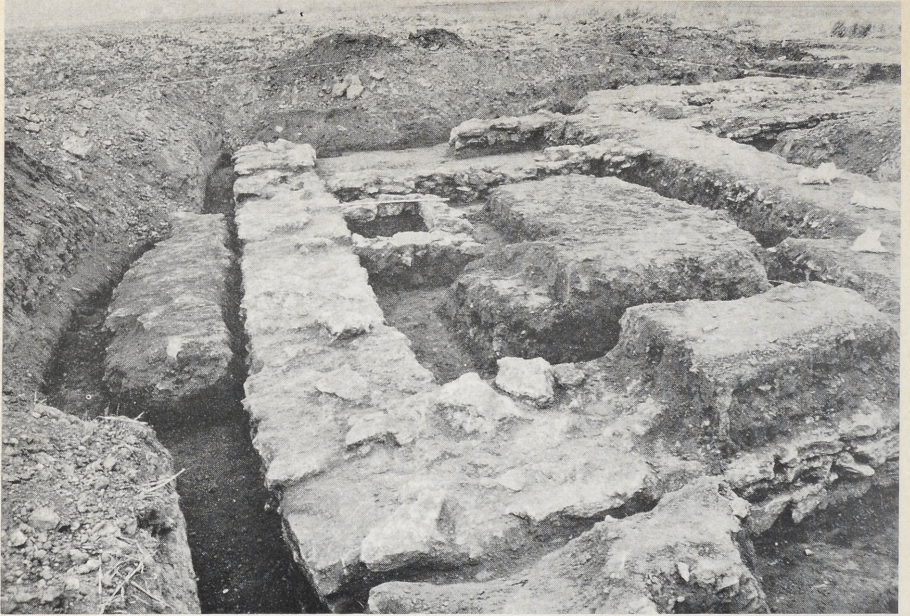
1 Dorfkirche Oldendorp Hausanbau mit Herdstelle an der Nordseite der Kirche (Westansicht)
