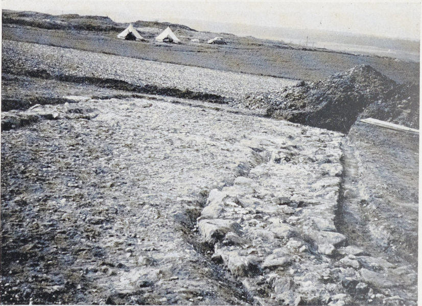
Blick auf das Tor nach Nordwesten
