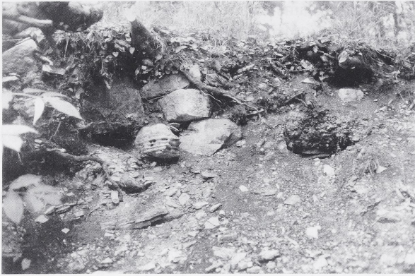
Abb. 4 Trockensteinmauer im Wallschnitt des Hauptwalles im Südwesten der Befestigung „Krimmelburg“.
