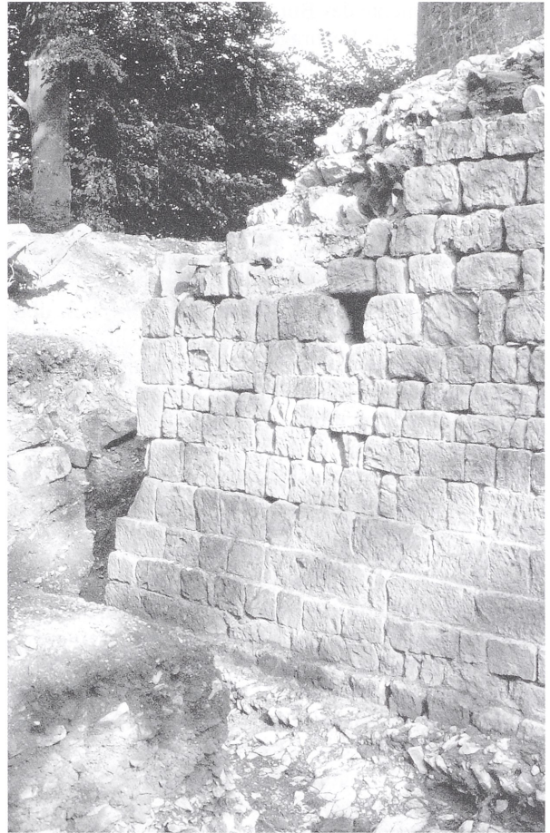
Abb. 13 Iburg bei Bad Iburg, Ldkr. Osnabrück. Turm des späten 11. Jhs./um 1100 am Nordwestende der Iburg. Foto: H.-W. Heine.
