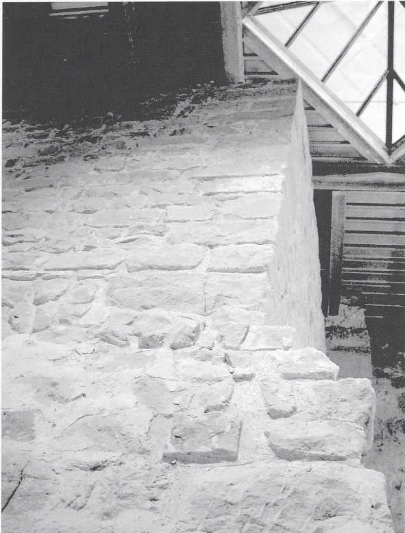
Abb. 17 Marburg. Im Untergeschoss des Schlosses. Unten sichtbar die Mauern des Rechteckbaues der Zeit um 1000; darüber gesetzt der spätere Turm, um 1100. Foto: Hans-W. Heine.
